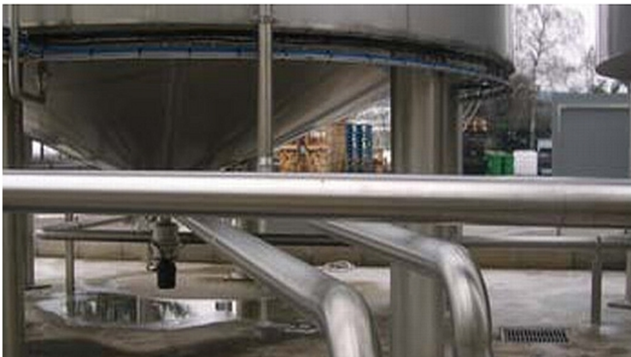
L'entreprise CLM conçoit et fabrique des sous ensembles mécaniques pour la filière nucléaire.
